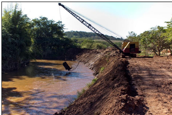
Figura 112 - Exemplo de Alargamento e Desassoreamento.
