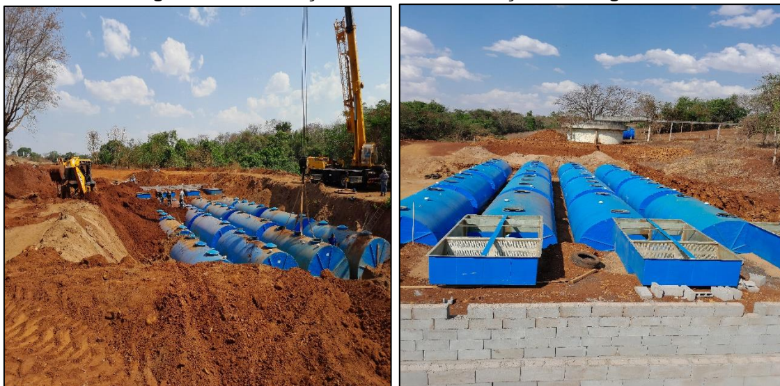
Figura 71 - Construção da ETE em Conceição das Alagoas.
