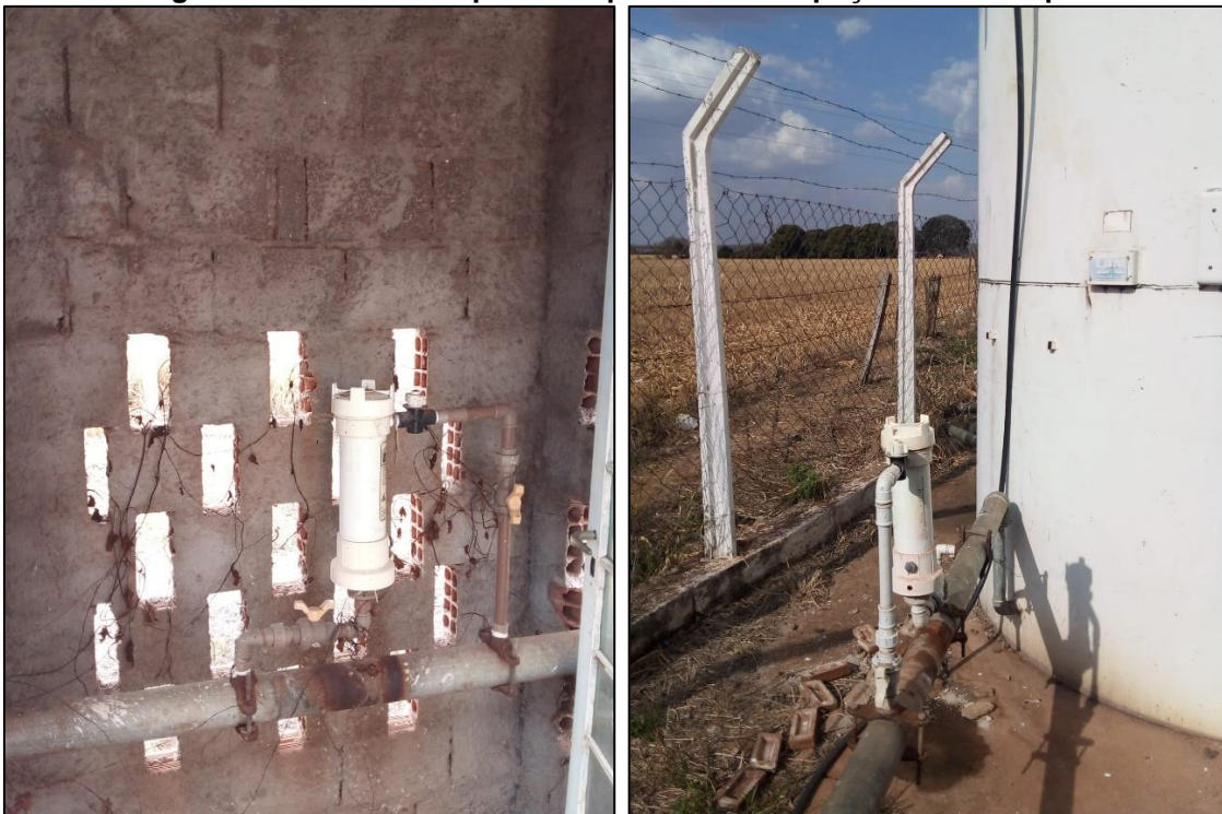
Figura 21 - Clorador de pastilhas presentes nos poços do município.
