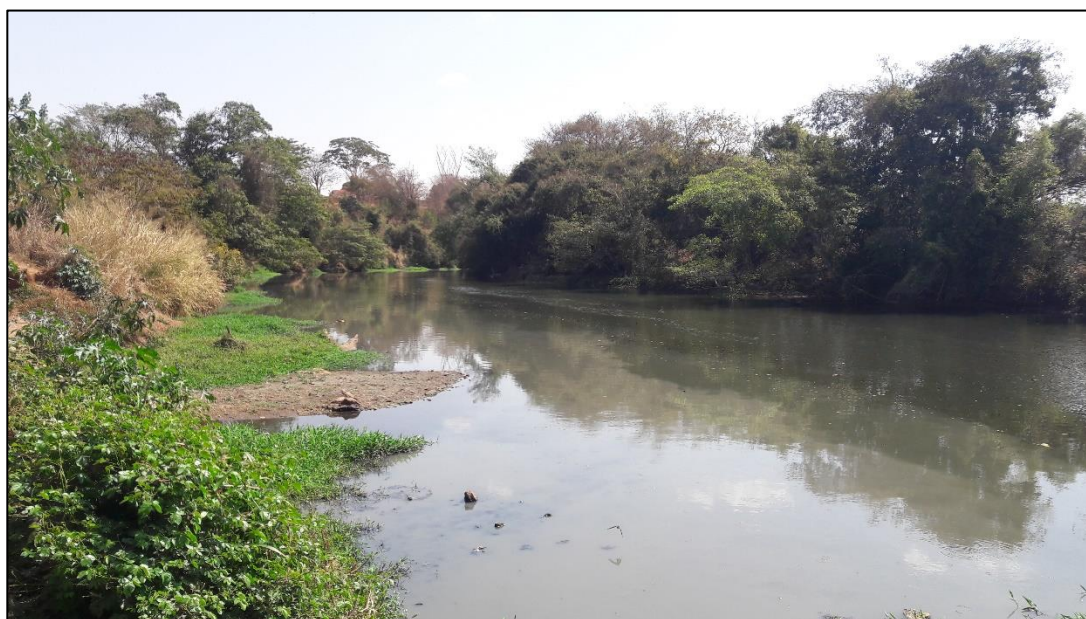
Figura 63 - Macrodrenagem em Conceição das Alagoas.
