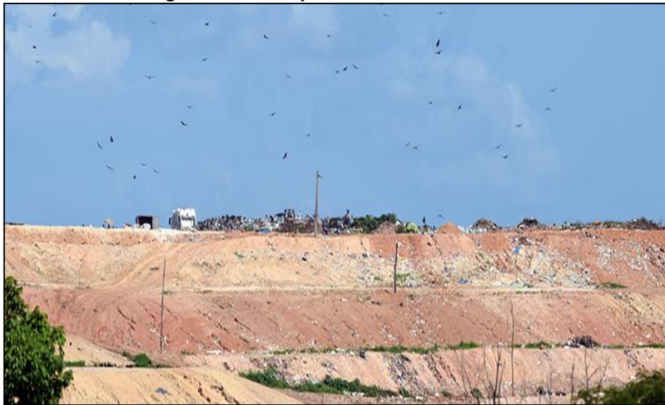
Figura 52 - Exemplo de aterro controlado.
