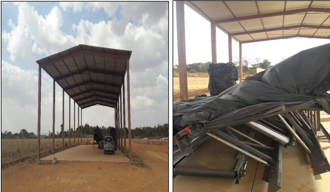
Figura 36 - Galpão da Cooperativa de Trabalho dos Recicladores Garimpenses – COOREG sendo implementado e esteira rolante aguardando a montagem.
