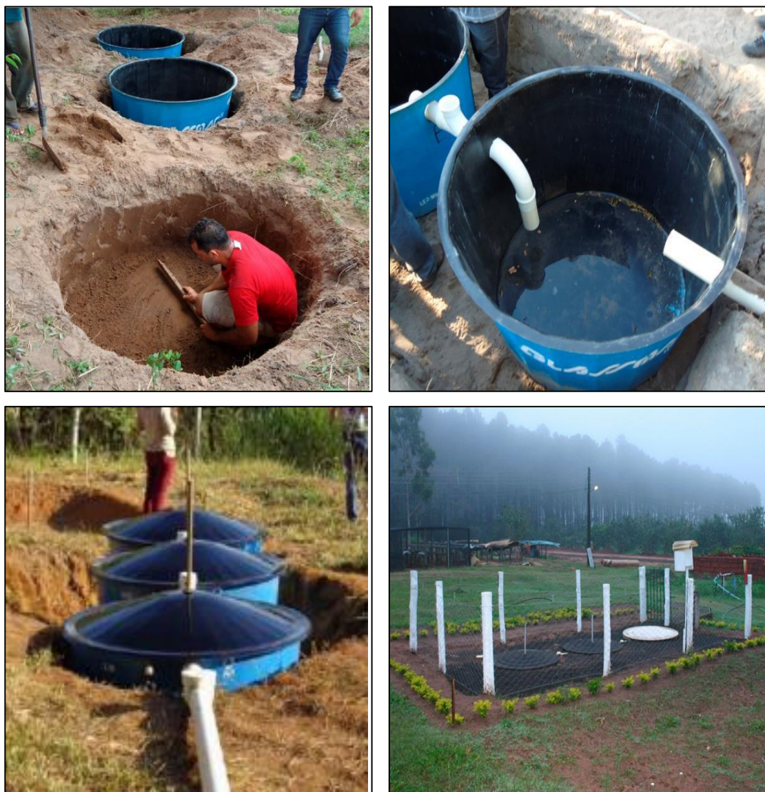
Figura 77 - Exemplo de instalação da fossa biodigestor.
