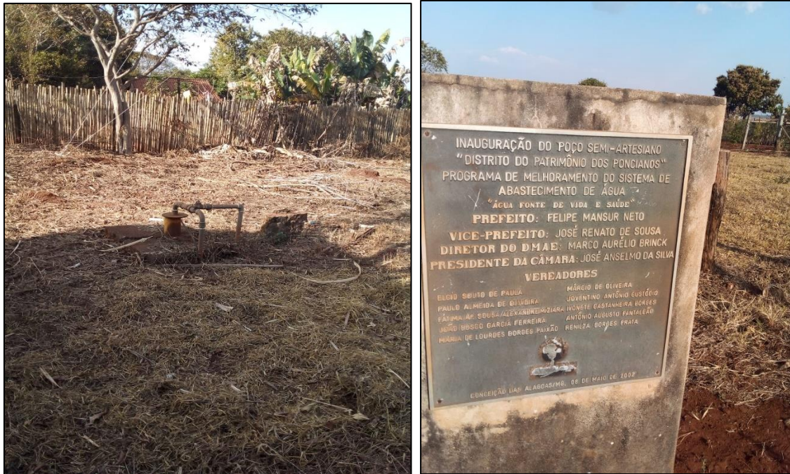
Figura 18 - Captação de água subterrânea no Distrito de Patrimônio dos Poncianos.
