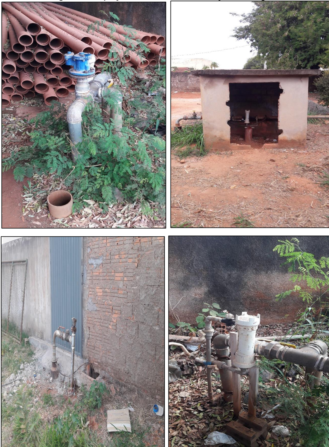
Figura 17 - Captação subterrânea em Conceição das Alagoas.
